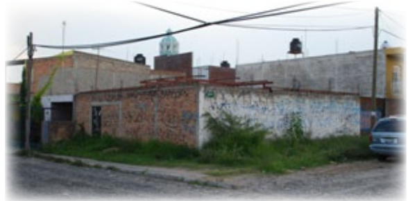
Local de Zapopan en construcción
